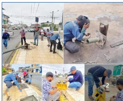
GRÁFICO 9 MANTENIMIENTO CORRECTIVO EN BASES DE BÁCULO DE LA INTERSECCIÓN SEMAFÓRICA SECTOR 5 ESQUINAS.
